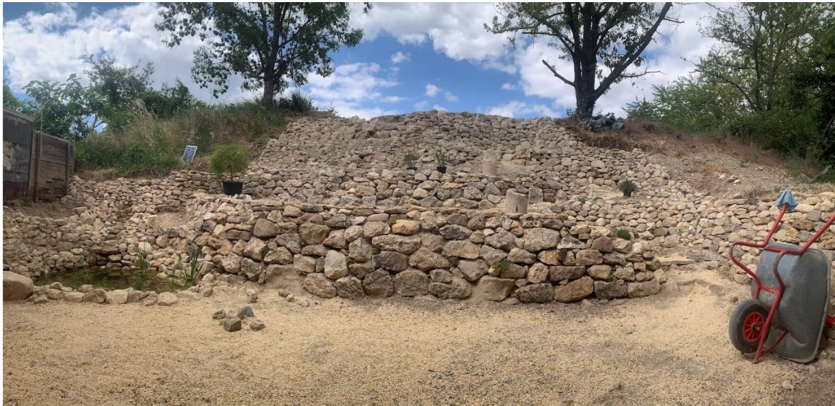
Abbildung 6: Hanggarten, Sicherung des Geländes in Trockenmauerbauweise
