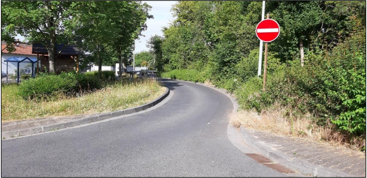
Abbildung 6: Einbahnstraße (Bahnhofstraße) zwischen beiden Grünflächen (Foto: ENVIRO-PLAN 2023)
