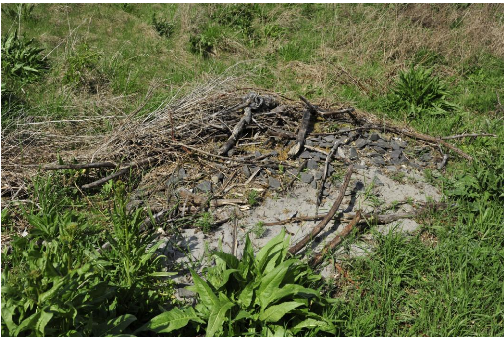
Abbildung 3: Beispiel einer kombinierten Stein-, Sand- und Totholzschüttung in einer Böschung.
