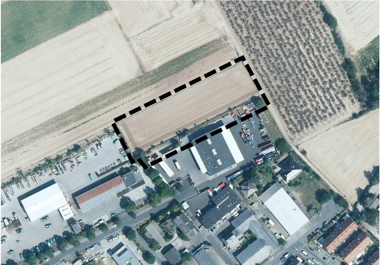
Luftaufnahme mit Abgrenzung des Geltungsbereichs; Quelle Kartengrundlage: Landesamt für Vermessung und Geobasisinformation Rheinland-Pfalz, Luftbild (2020), ohne Maßstab, Koblenz
