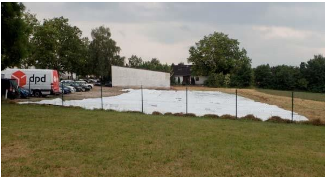
Abgedeckter Baubereich Stand 04.06.2020 (Quelle: Viriditas 20.06.2020)
